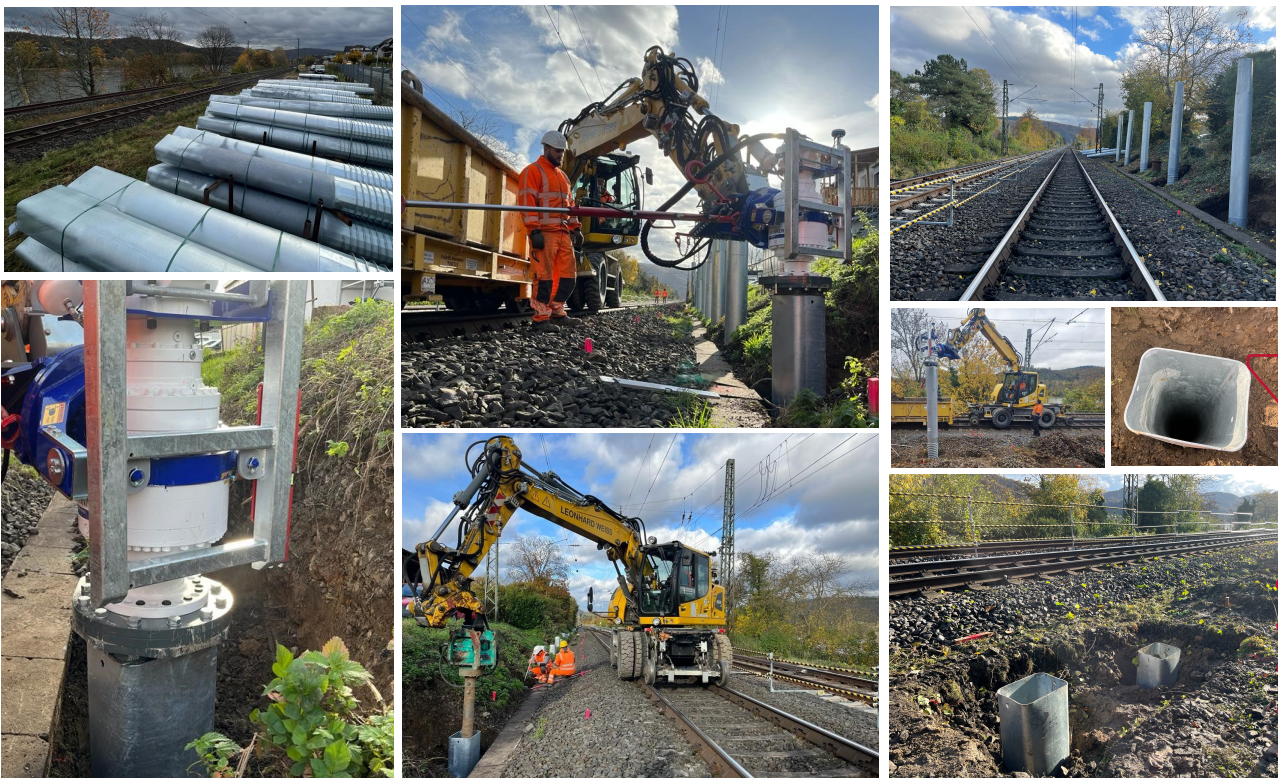
Exemplarische Darstellung einer Lärmschutzwand auf KRINNER Schraubfundamenten
